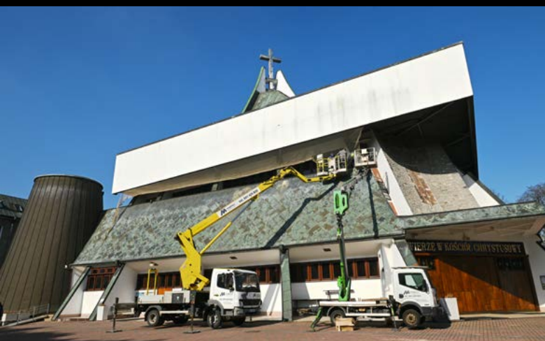
III PRACE REMONTOWE NA BUDYNKU KOŚCIOŁA FOT. BR. PAWEŁ GONDEK
